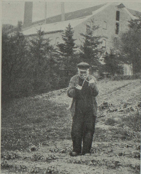
Fig. 1. Rørlægger Engstrøm passerer vandaaren med ønskevisten. Kvisten slaar op og brækkes. (Fot. G. H., 6te mai 1925).
